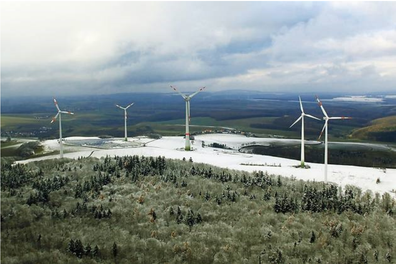
E-126 ist die größte Windkraftanlage der Welt. Sie steht in Rheinland-Pfalz.
