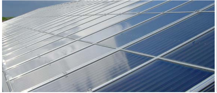
Die hochselektiven TiNOX-Absorber verwerten etwa 90 % der einfallenden Solarstrahlung.
